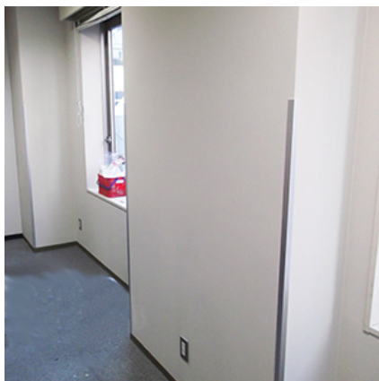
柱塗装後コーナーガード取付
