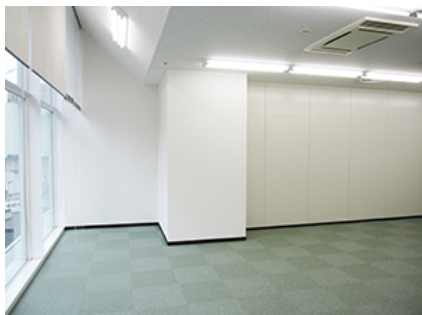
壁柱塗装後カーペット張替
